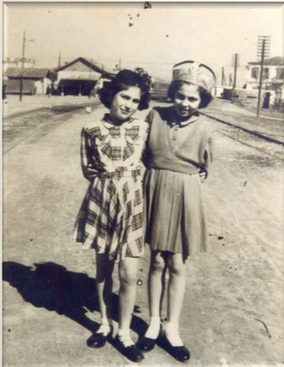
Μπροστά στον επιβατικό σταθμό (σημερινό ΚΑΠΗ)
