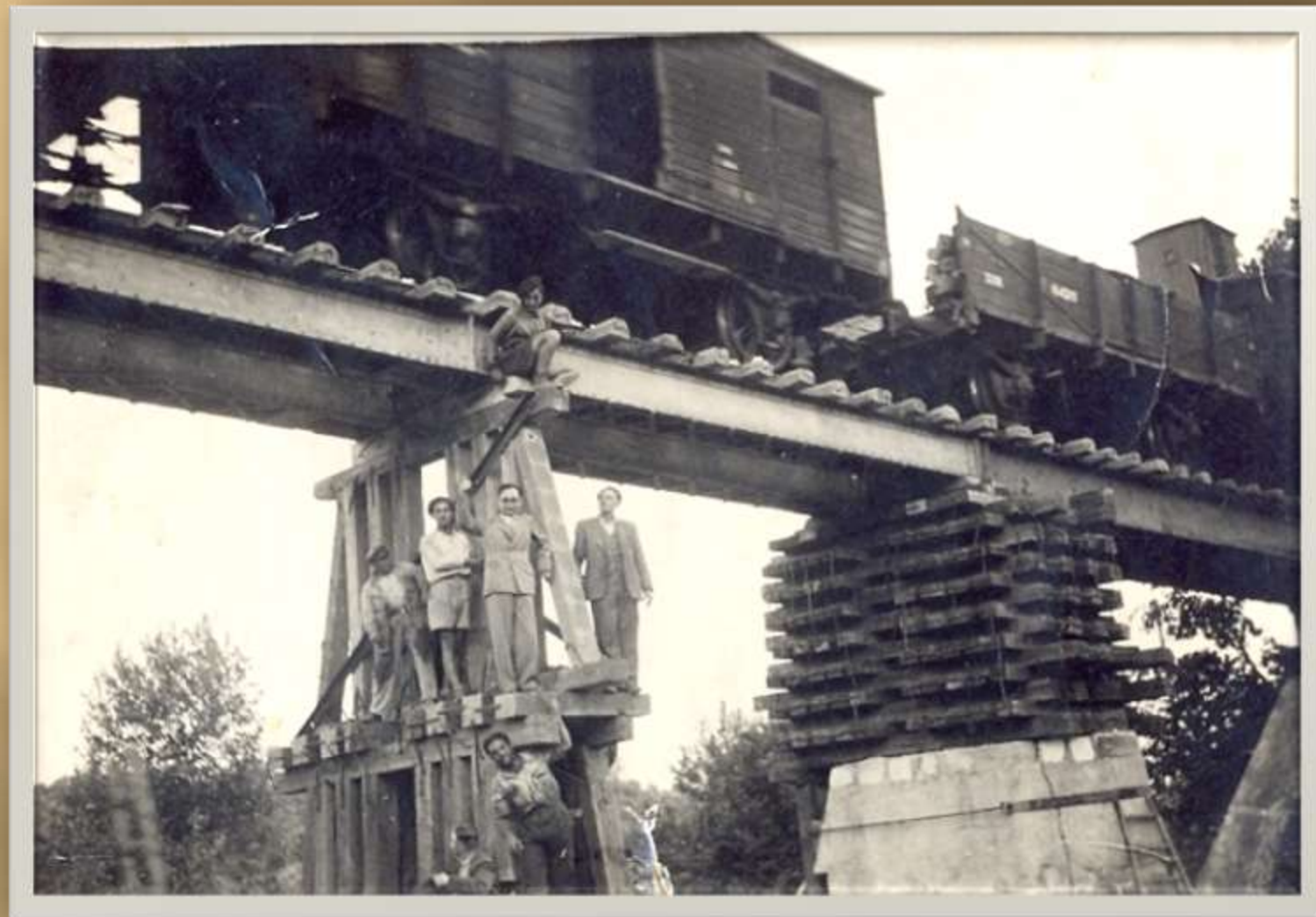
Επισκευή γέφυρας μετά από ανατίναξη στον εμφύλιο 1947-48
